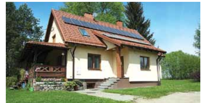
W programie „EWA plus” można ubiegać się o pożyczki np. na budowę źródeł energii czy też termomodernizację domu Fot. Grzegorz Siemieniuk
